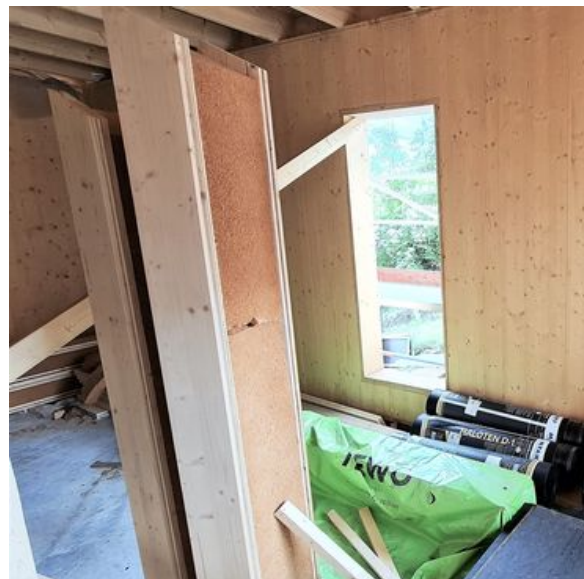
Veggene bygges av elementer med ferdig innlagt trefiberisolasjon. Foto: Knut Bjørheim
