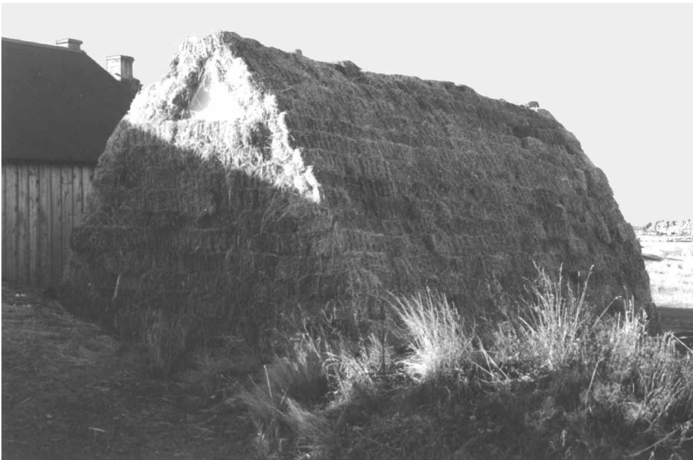
Provisorisk halmballhus med hvelvkonstruksjon bygget av studenter på Lista, høst 1993.
